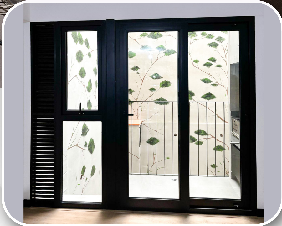
VENTANAS TERMOACÚSTICAS EN LA SALA Y DORMS.
