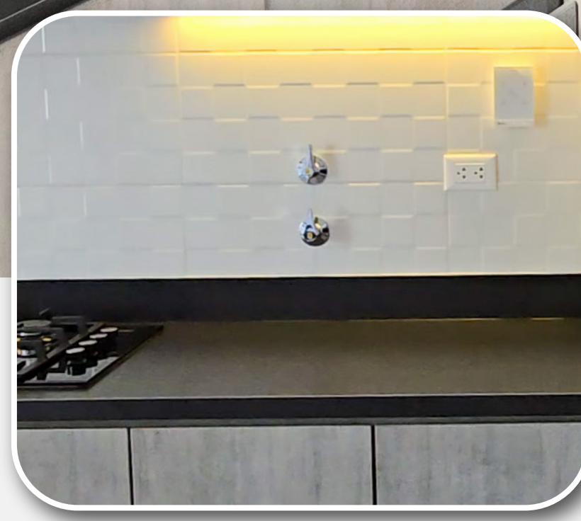
PIEDRA SINTERIZADA EN LA COCINA
